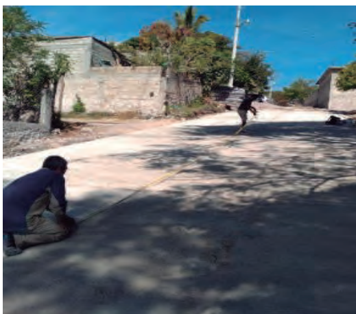
COL. ANTONIO RIVAPALACIO (LAS CARPAS) PAVIMENTACIÓN CON CONCRETO HIDRÁULICO EN LA CALLE DE LA CRUZ
