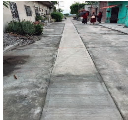
COL. LOS PRESIDENTES REHABILITACIÓN DE DRENAJE SANITARIO EN LA CALLE JUAN ÁLVAREZ
