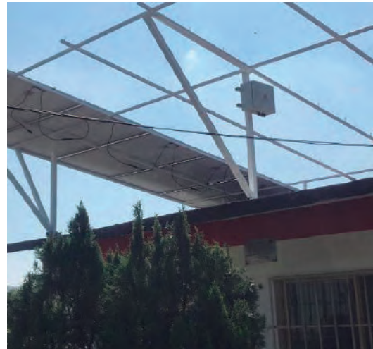
XOCHIPALA REHABILITACIÓN DE FUENTE DE ABASTECIMIENTO DE AGUA POTABLE DE LA LOCALIDAD DE XOCHIPALA
