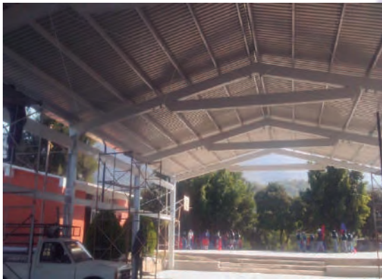
COL. 3 DE MAYO CONSTRUCCIÓN DE CUBIERTA METÁLICA EN CANCHA DE USOS MÚLTIPLES DE LA ESCUELA TELESECUNDARIA "NIÑOS HEROES" DE LA COL. 3 DE MAYO
