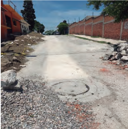
COL. LOS PRESIDENTES REHABILITACIÓN DE DRENAJE SANITARIO EN LA CALLE ADOLFO LÓPEZ MATEOS
