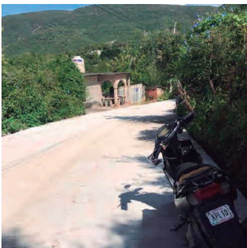
COL. 3 DE MAYO PAVIMENTACIÓN CON CONCRETO HIDRÁULICO EN CALLE LAURO ORTEGA
