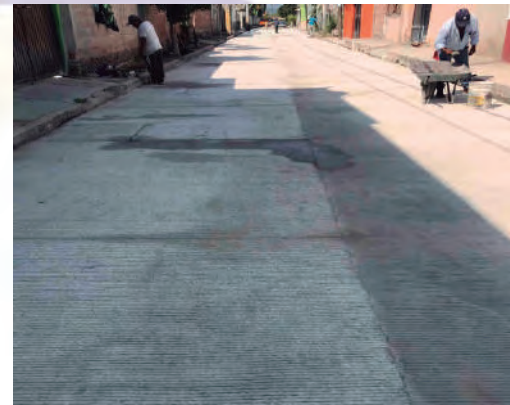
COL. CELERINO MANZANARES REHABILITACIÓN DE DRENAJE SANITARIO EN LA CALLE "EL PIPILA"
