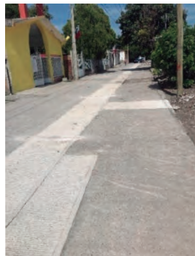
COL. LOS PRESIDENTES REHABILITACIÓN DE DRENAJE SANITARIO EN LA CALLE JUAN ÁLVAREZ
