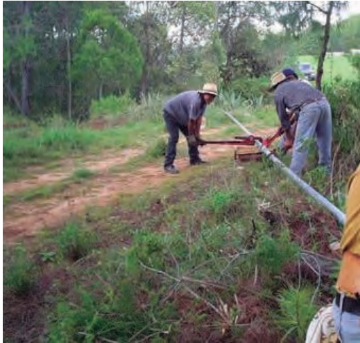
SANTIOPAN REHABILITACIÓN DE LÍNEA DE CONDUCCIÓN DE AGUA POTABLE EN LA LOCALIDAD DE SANTIOPAN
