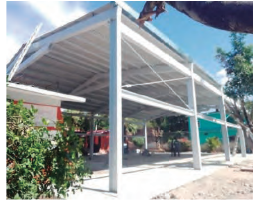
QUILAMULA CONSTRUCCIÓN DE CUBIERTA METÁLICA EN CANCHA DE USOS MÚLTIPLES DE LA ESCUELA PRIMARIA "EMILIANO ZAPATA" DE LA LOCALIDAD DE QUILAMULA
