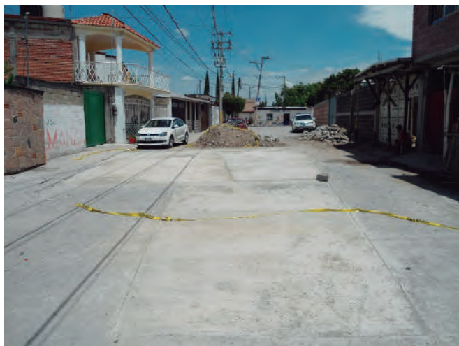
COL. CELERINO MANZANARES REHABILITACIÓN DE DRENAJE SANITARIO EN LA CALLE GABRIEL TEPEPA
