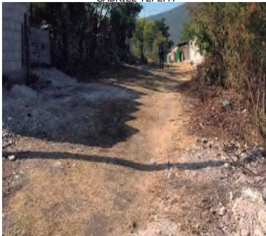
LAS BÓVEDAS AMPLIACIÓN DE RED DE DISTRIBUCIÓN ELÉCTRICA EN LA CALLE CORREGIDORA
