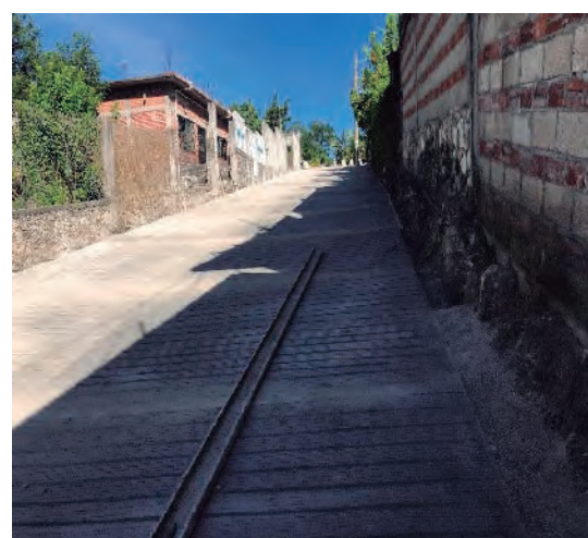
COL. 3 DE MAYO PAVIMENTACIÓN CON CONCRETO HIDRÁULICO EN CALLE LAURO ORTEGA
