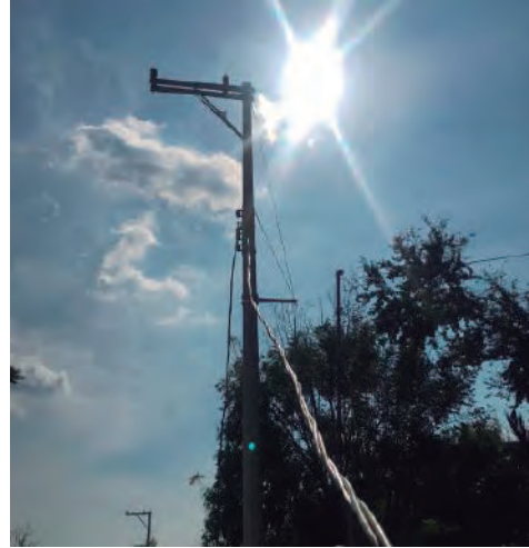
COL. PALO GRANDE AMPLIACIÓN DE RED DE DISTRIBUCIÓN ELÉCTRICA EN LA CALLE EL LIMONCILLO
