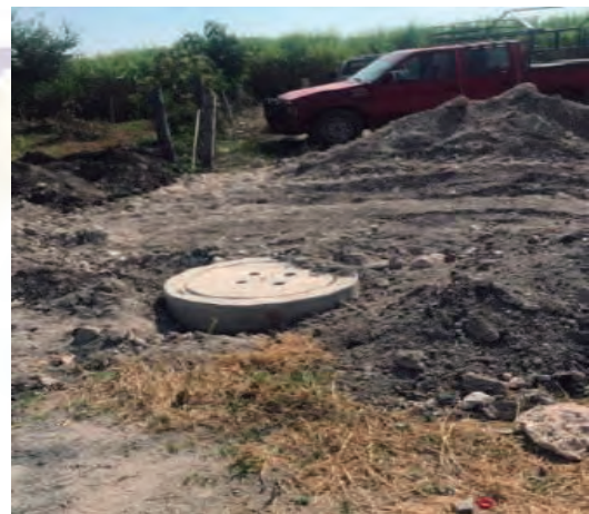
COL. MIGUEL HIDALGO CONSTRUCCIÓN DE DRENAJE SANITARIO EN LA CALLE LÁZARO CÁRDENAS
